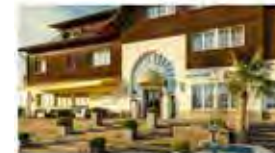
Hotel Seendöwe**** Güdingen, Ostschweiz
